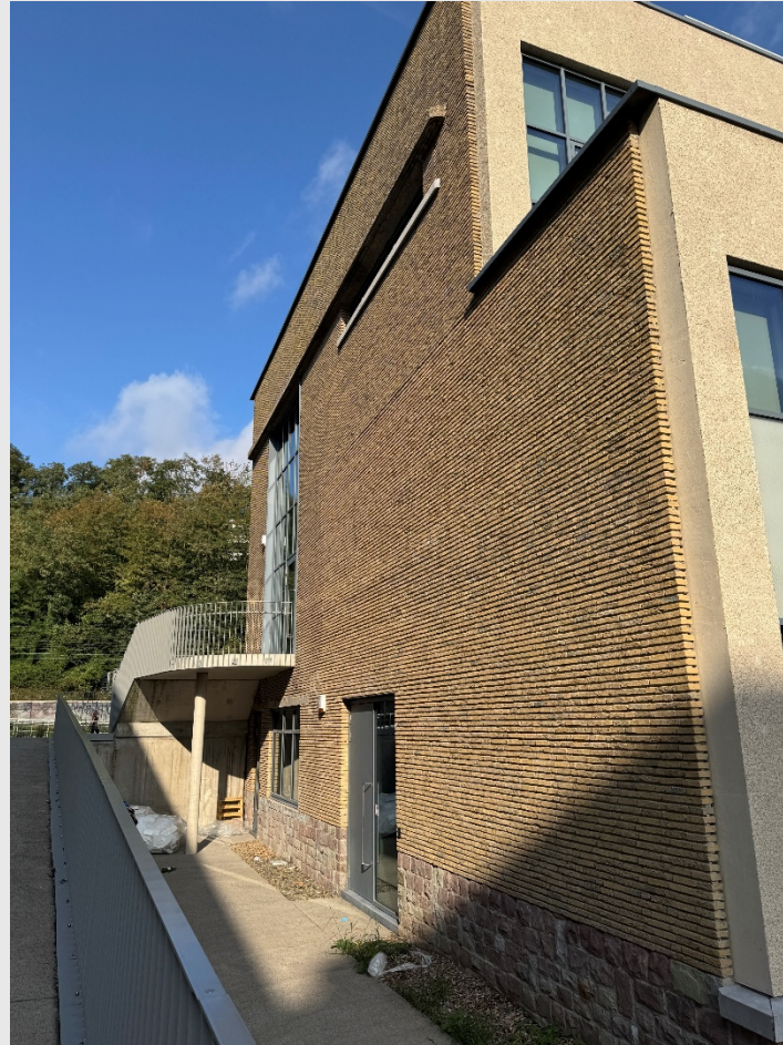
Le pignon de la Centrale a été restructuré à l'aide de briques récupérées
