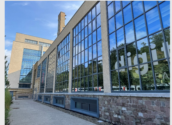
Le soubassement de la façade remaniée côté E. Solvay est fait de moellons récupérés
