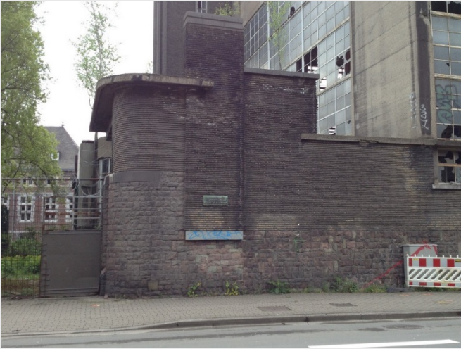
Tri de matériaux de déconstruction en vue d'une réutilisation
