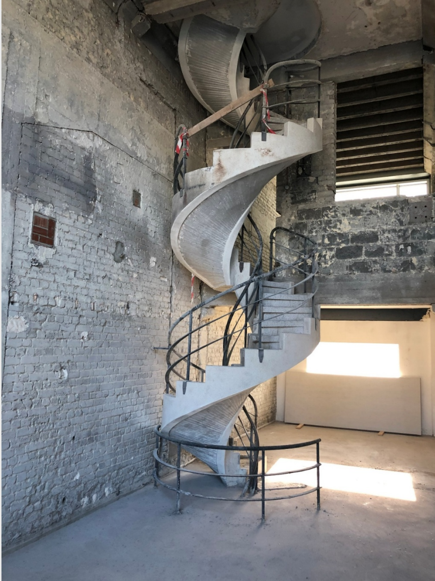
Conservation in situ d'un escalier
