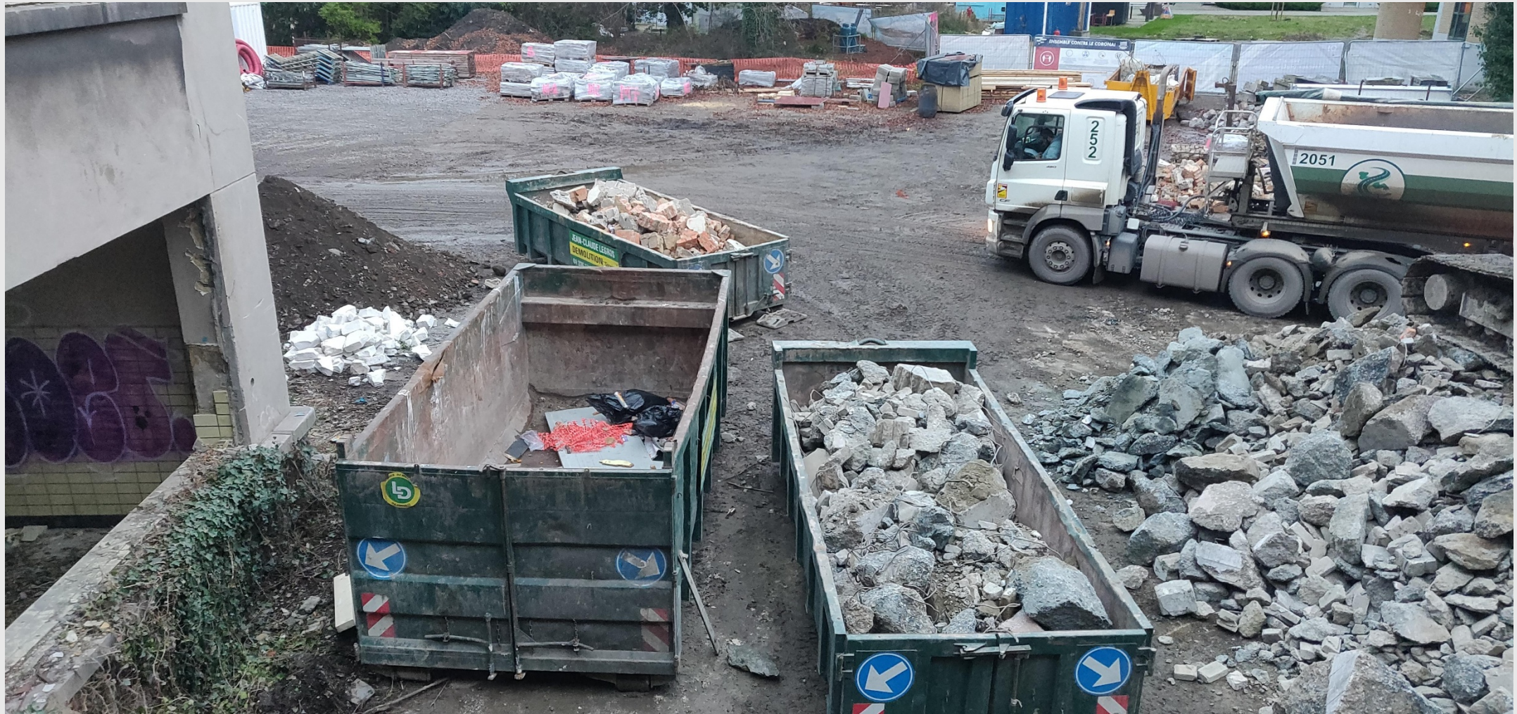
Stockage de gravats concassés pour être réutilisés en fond de coffre
